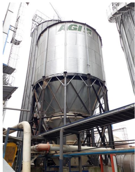
Imagen 1. Silo de almacenamiento
